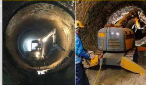
Servicio especializado de demolición de revestimiento interior en tubos de hornos de cemento, realizado con maquinaria avanzada compuesta por retroexcavador sobre cadenas de diversos tamaños, equipadas con martillo hidráulico picador, y mini-pala cargadora sobre ruedas para la evacuación por escobilla de materiales resultantes de la demolición.
